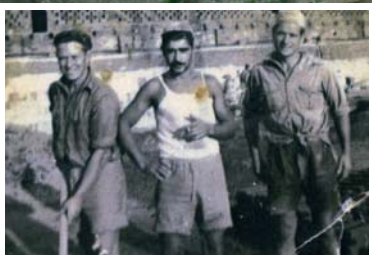
Tres treballadors de l'empresa Luís Serret fent una obra a la zona d'Artigues, any 1953.
